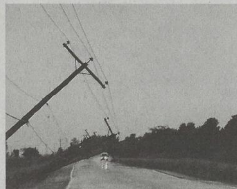
Une vingtaine de poteaux électriques tombent sur la route 138 entre Maskinongé et Saint-Barthélemy, suite à un violent coup de vent.
