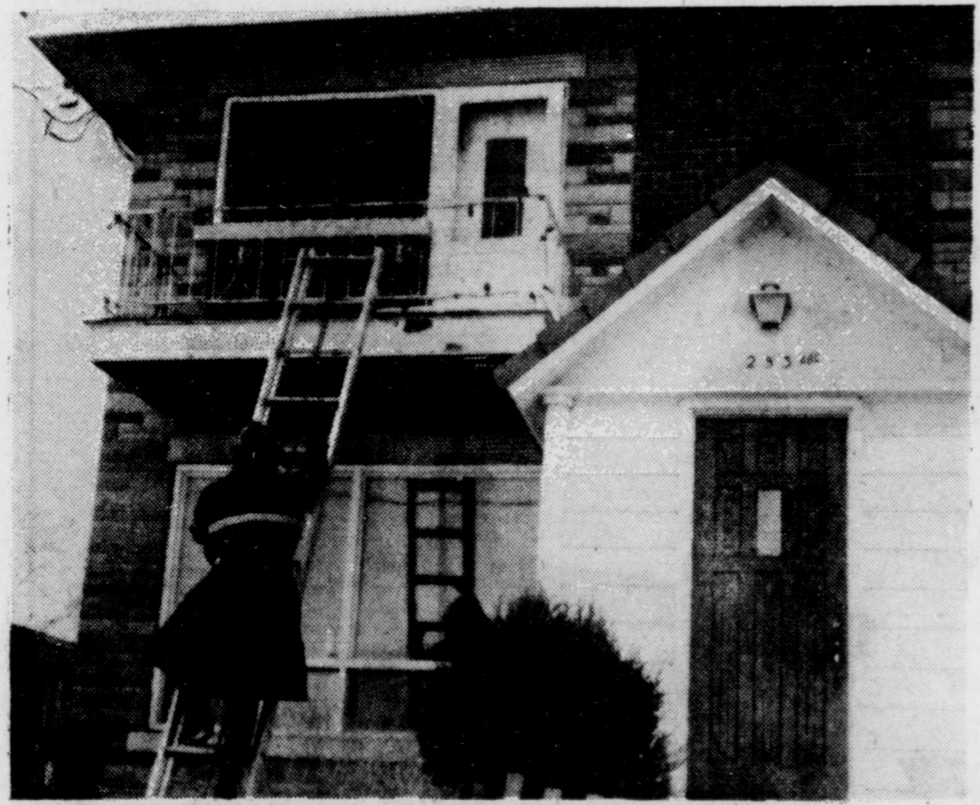
Les pompiers de la ville de Sorel ont dû briser la fenêtre avant du logement situé au 253 B, Chemin Saint-Ours pour pénétrer à l'intérieur et maîtriser l'incendie qui s'est déclaré hier avant-midi alors que les locataires, M. et Mme Rodrigue Champagne, étaient absents. Les dommages au logement incendié et aux autres logements de l'édifice sont évalués provisoirement à quelque $12,000. (Photo Gariépy).
