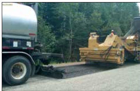
Séquence de construction d'un traitement de surface
