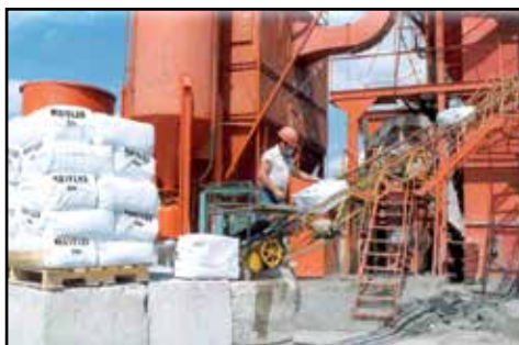
Figure 1 : Manipulation des sacs contenant de l'amiante en centrale. Source : MTQ
