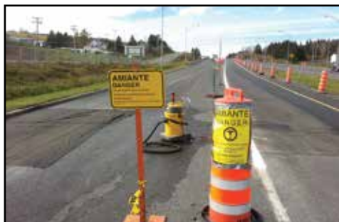
Figure 5 : Exemple de délimitation de zone de travail. Source : Jean Leclerc Excavation Inc.
