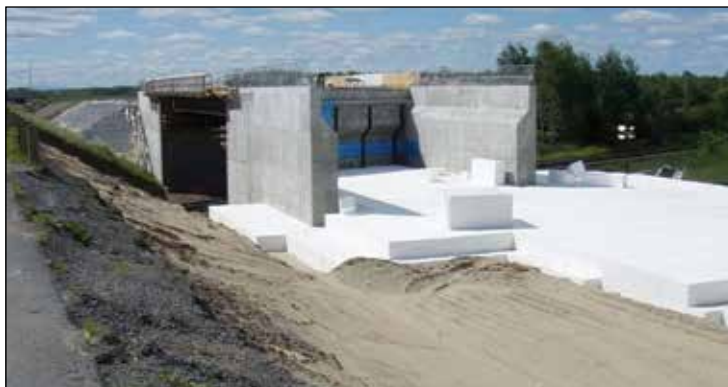
Figure n° 5 : Remblai d'approche léger échangeur A20/A30/A540
