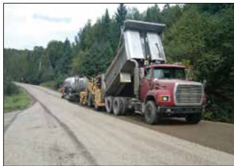
Séquence de construction d'un traitement de surface
