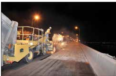
Travaux pont Champlain
