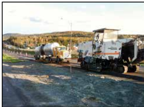
Figure 2 : Planage de l'EA selon la méthode stabilisée. Source : Jean Leclerc Excavation Inc.
