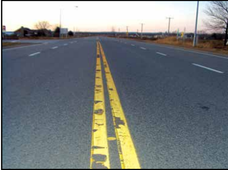
Figure 3 : Arrachement d'époxy appliqué sur un marquage à l'époxy (2 couches)
