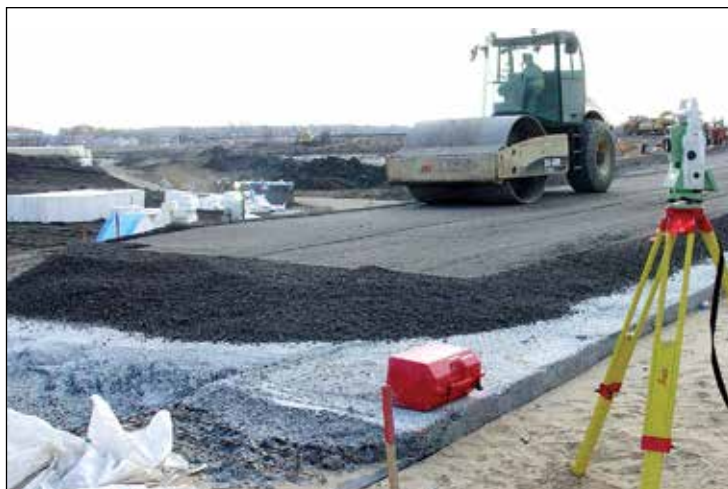
Figure n° 6 : Structure de chaussée sur remblai léger
