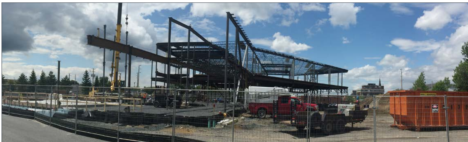
Le chantier de la future bibliothèque.
