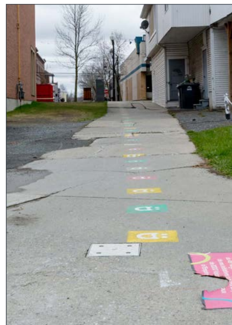
Le Passage blanc, avant les travaux de réfection.
