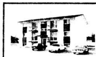
784 BON DESIR Bloc appartement de 6 logements de 4 1/2 pces. Très rentable.
