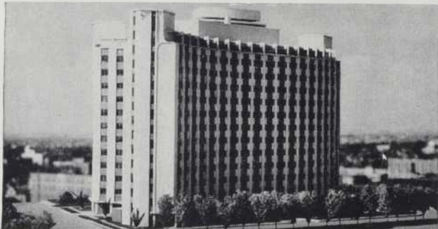
Immeuble : Siège social, Saskatchewan Power Corporation, Regina Propriétaire : Gouvernement de la Saskatchewan Architecte : Joseph Pettick, Regina Entrepreneurs généraux : Commonwealth Construction Co. Ltd., Winnipeg
