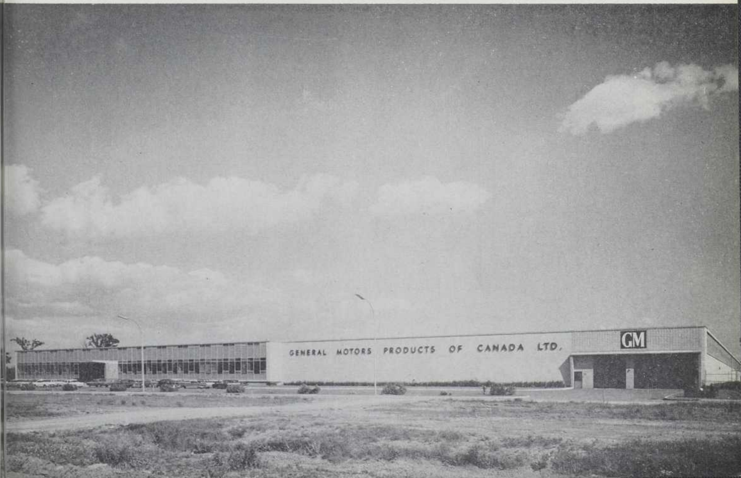
Elévation nord-ouest, prise du nouveau boulevard Métropolitain, en construction.
