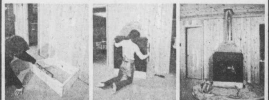
Le socle est construit et mis au niveau sur le plancher.
