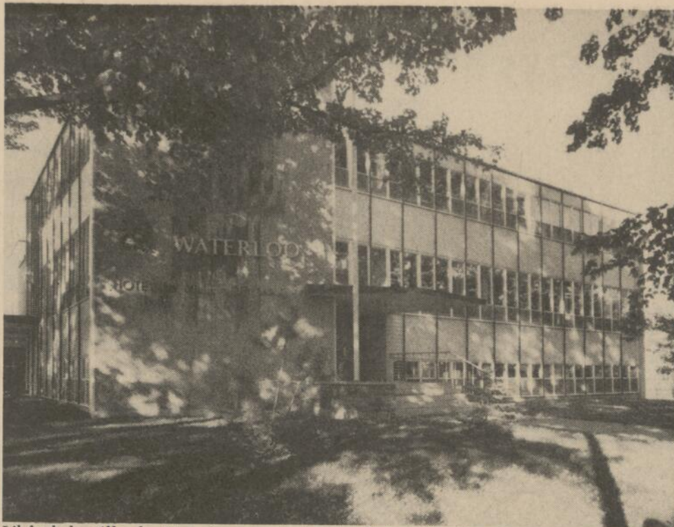
L'hôtel de ville de Waterloo, construit sous l'administration de M. Armand Russel répond aux nécessités des temps présents et abrite en plus de l'administration municipale, le poste de police, et la caserne des pompiers.
