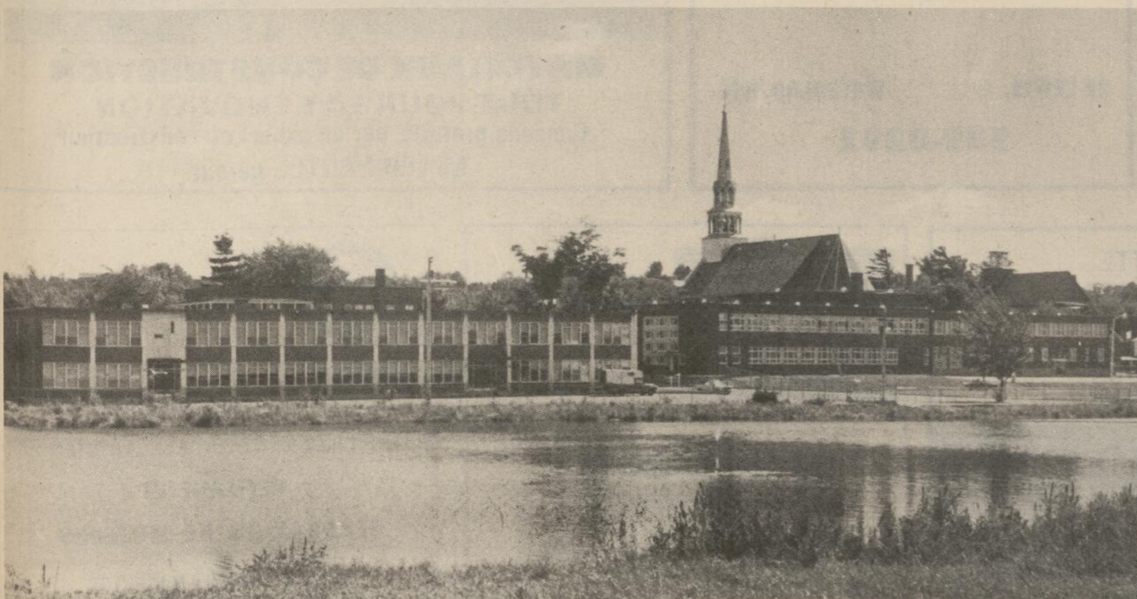
Les deux écoles de Waterloo, l'ancienne, soit le collège Saint - Bernardin et la nouvelle, soit l'école Notre - Dame, sont construites côte à côte sur les rives de la rivière Yamaska, formant ainsi un complexe scolaire qui abrite d'autre part le centre administratif de la Commission scolaire.
