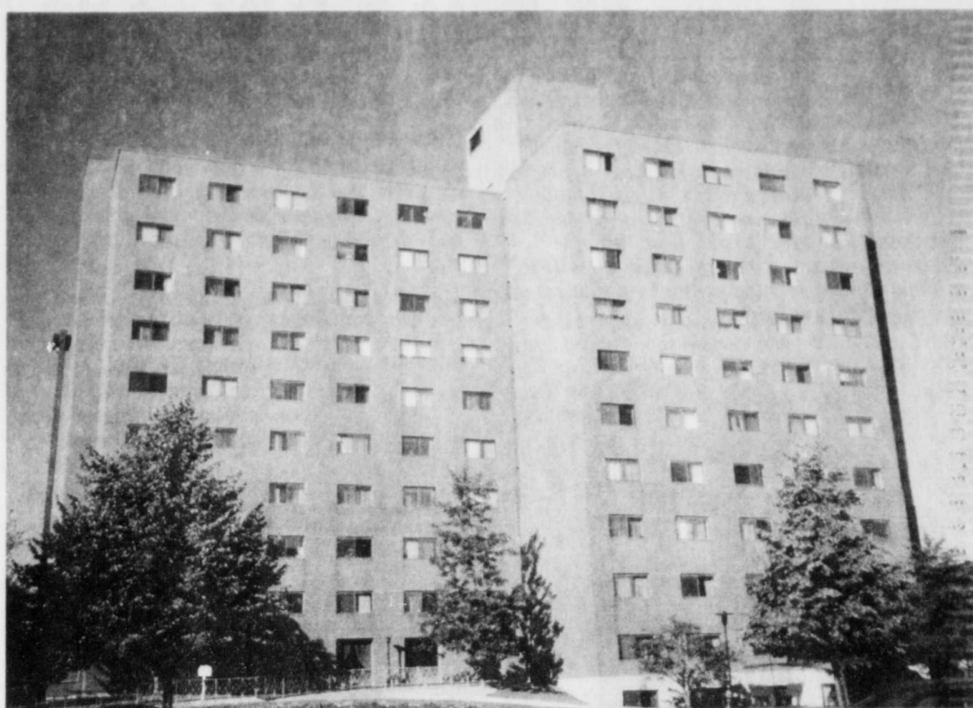
Situé dans le quartier Saint-Sacrement, l'édifice de La Champenoise offre une vue imprenable sur la ville de Québec.
