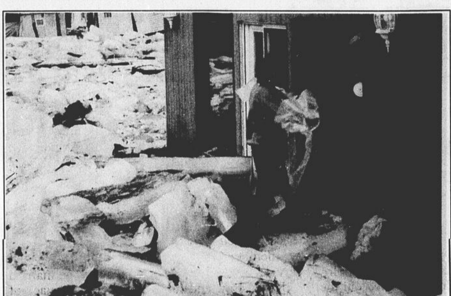
La résidence de Rolland Maheux d'Elgin a reçu la visite impromptue des glaces et des eaux de la rivière.
