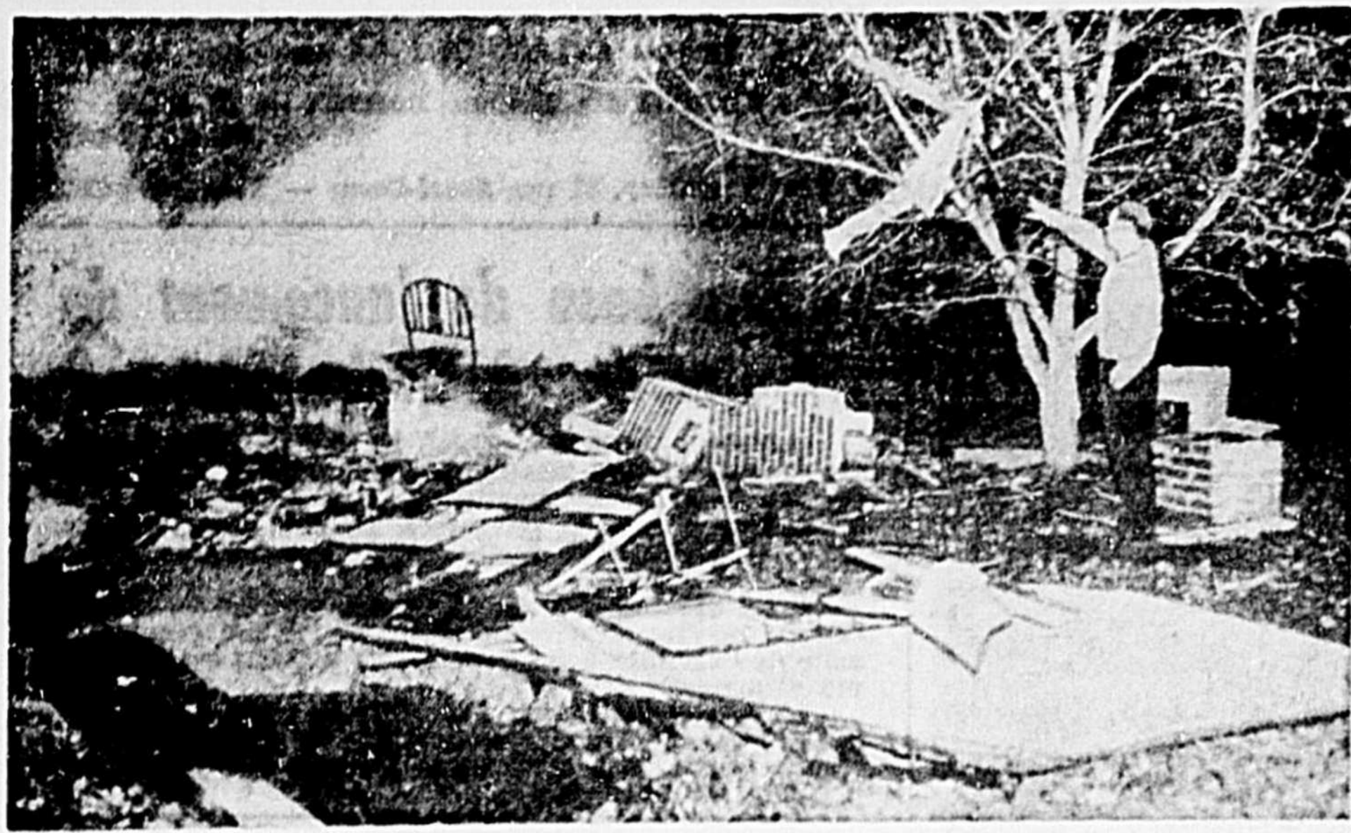
L'explosion d'une conduite de gaz a réduit cette maison en cendres, à Palermo, en Ontario. Mme Roy Skinner et son fils ont trouvé la mort. La mère et l'enfant sont restés coincés entre le plancher et le plafond qui s'était effondré.
