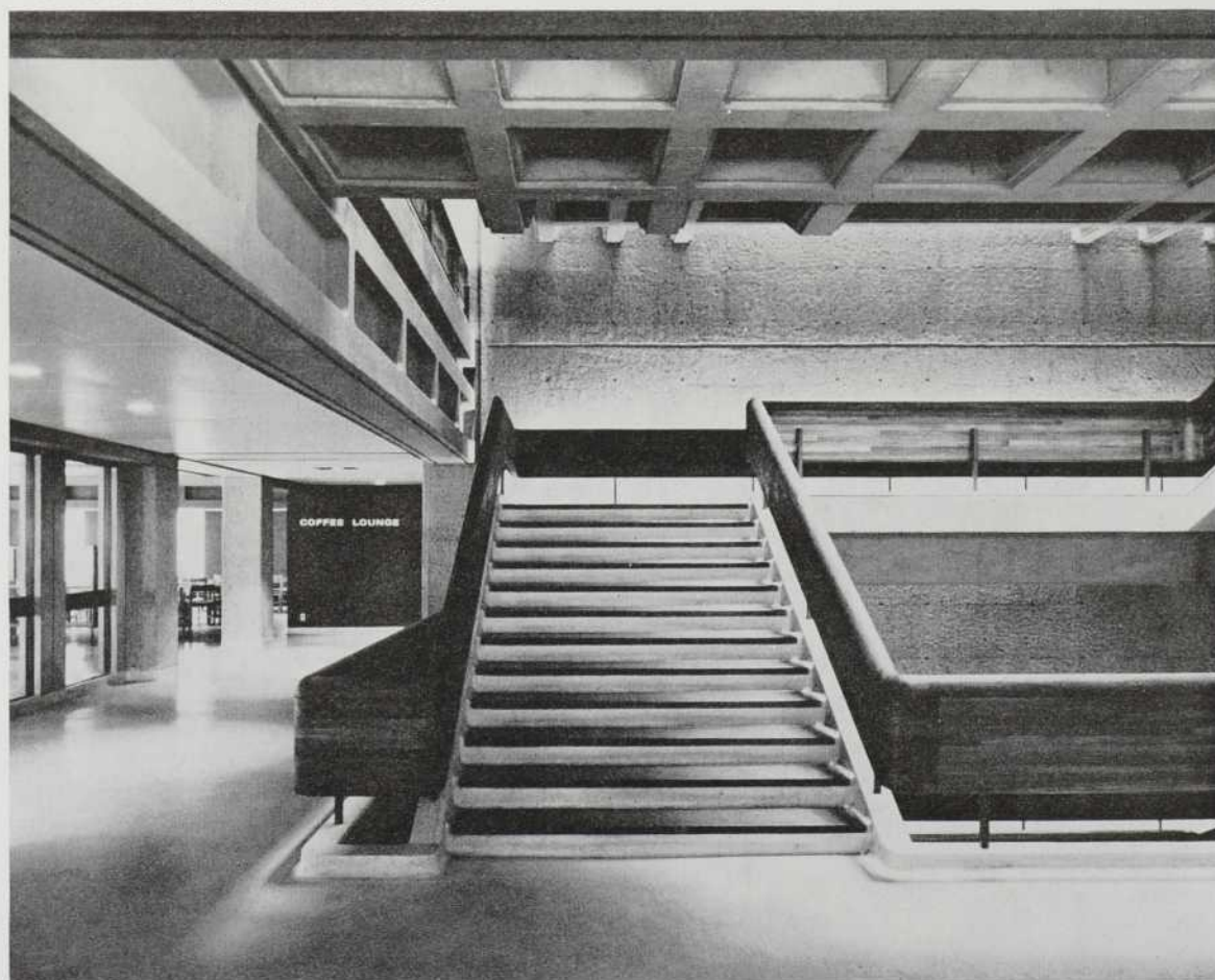
volée de l'escalier, également au 1er étage
