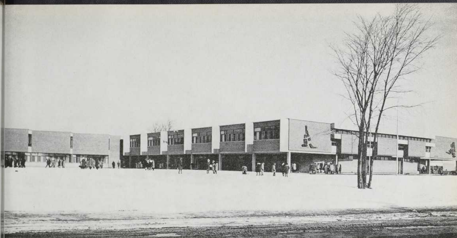
aspect de la façade sud, la bordure de la rue centrale
