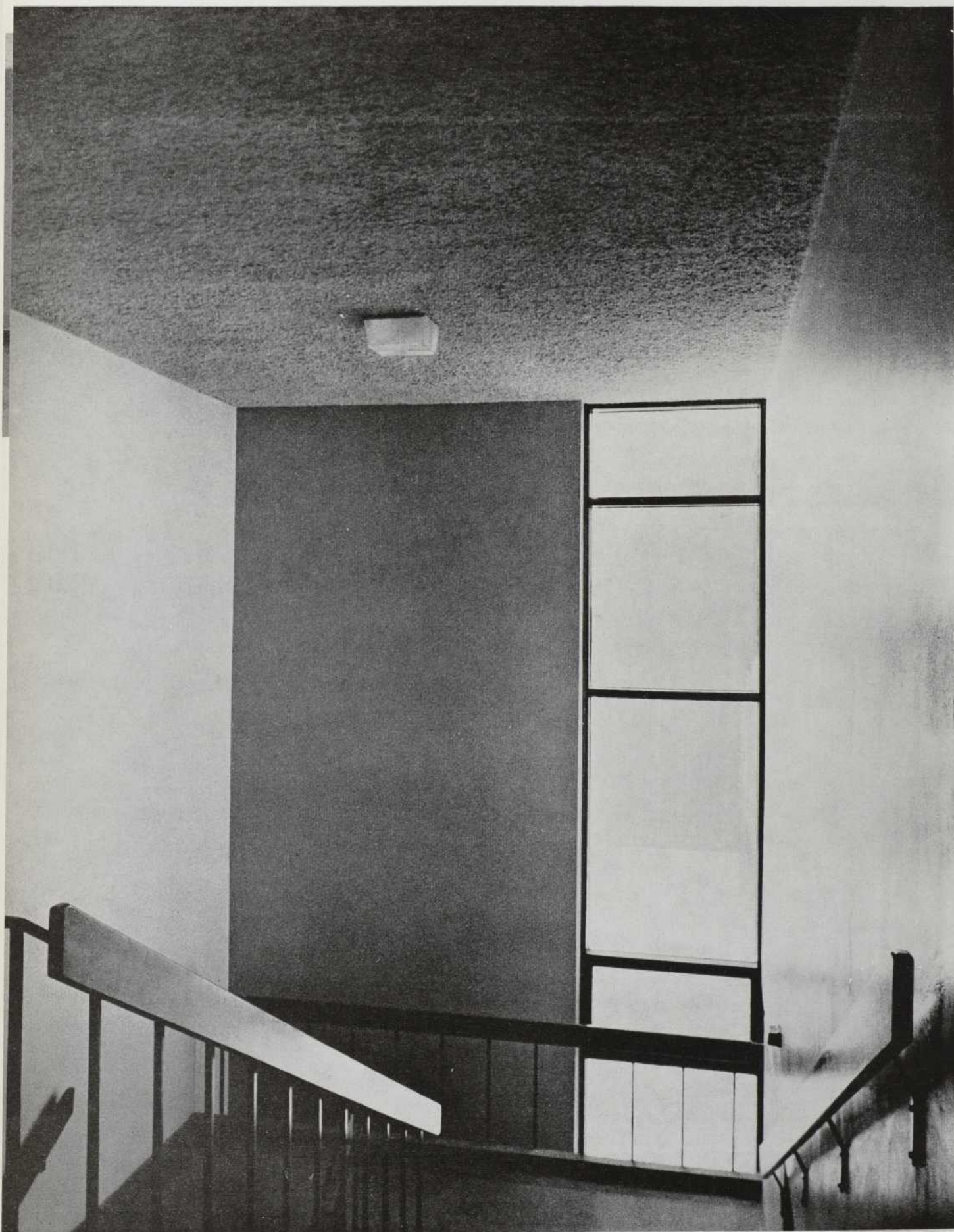
Cage d'escalier menant aux classes du 1er étage.
