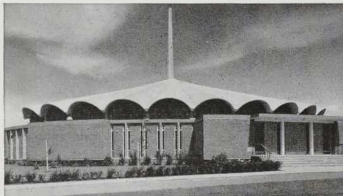
Église Sainte-Trinité, Calgary, Alta. Architectes: Cohos-Delesalle and Associates. Ingénieurs-conseils (structure): Lamb, T. McManus & Assoc. Ltd. Entrepreneur-général: Commonwealth Construction Co. Ltd. Fournisseur de béton préparé: Consolidated Concrete Ltd.
