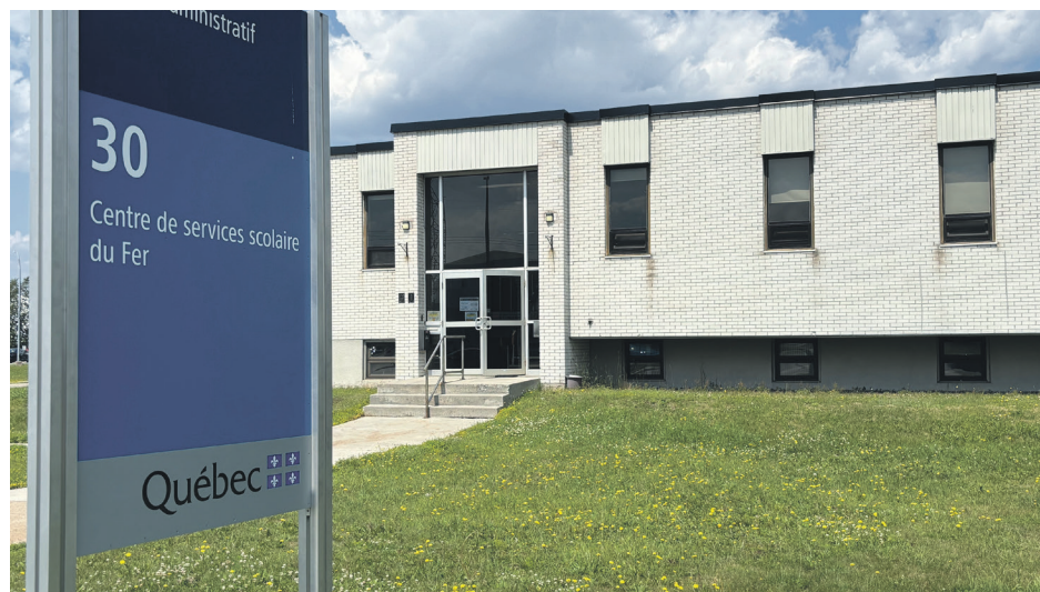
Les bureaux administratifs du Centre de services scolaire du Fer, sur l'avenue Comeau. Photo Sylvain Turcotte
