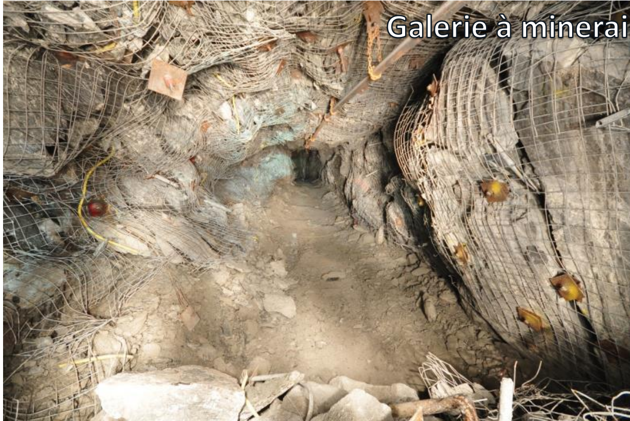
Photo #6 : Condition de terrain difficile
