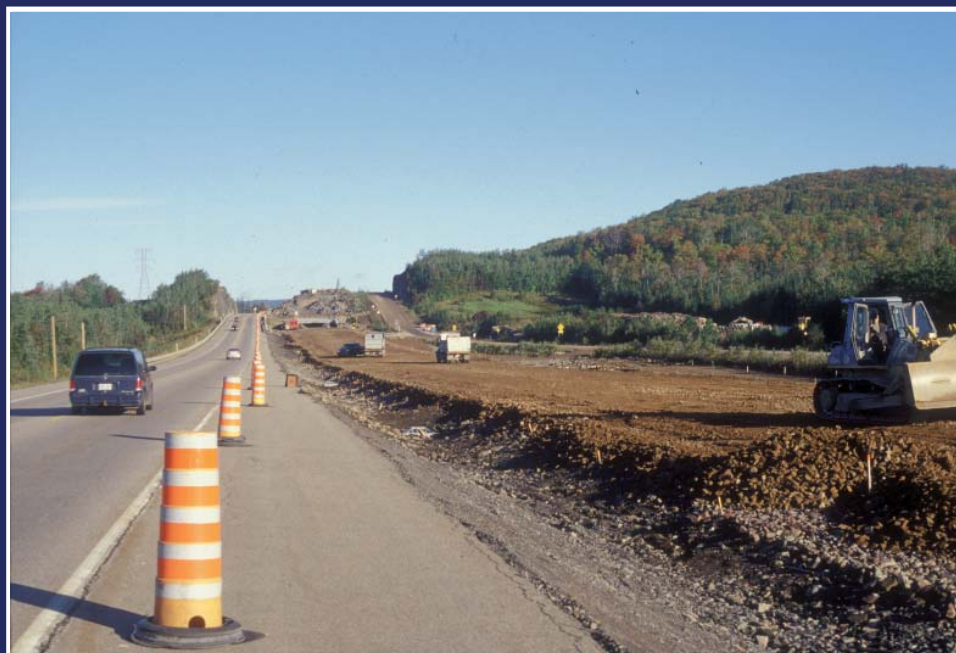
Construction de la route 175 dans la Réserve faunique des Laurentides.
