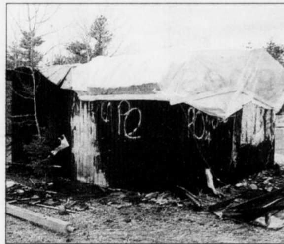
Un incendie a été volontairement allumé par trois adolescents, en fin de soirée, jeudi. Il s'agit du bâtiment adjacent au réservoir d'eau de la ville de Saguenay, situé sur la rue des Roitelets. Les trois jeunes ont été arrêtés peu de temps après le méfait.
