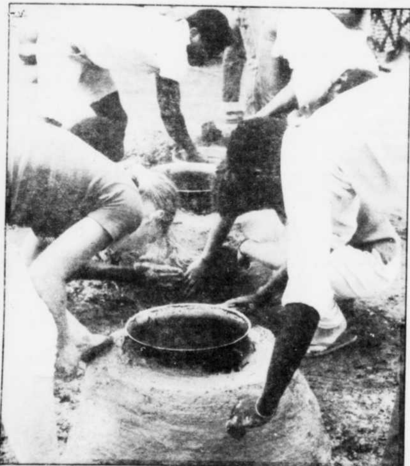
C'est de cette façon que l'on construit une place pour le feu. Presque ajustée à la grande marmite, cette masse de terre durcie économise le bois si rare en Afrique. Benoit Martel a enseigné la technique de construction et a convaincu des Maliens de continuer ainsi.
