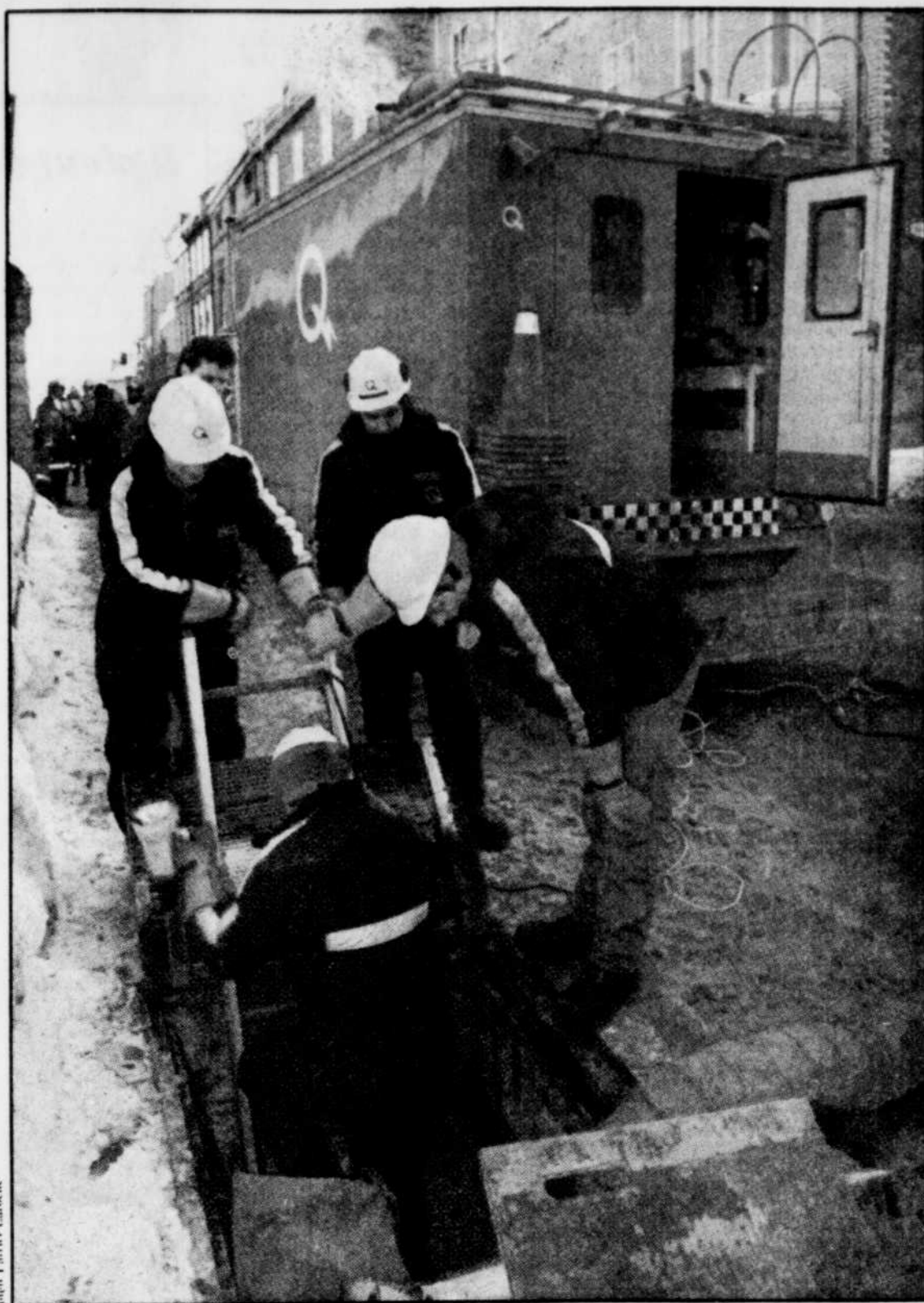
Les employés d'Hydro-Québec ont remplacé le câble sectionné et ont ensuite refait le filage.
