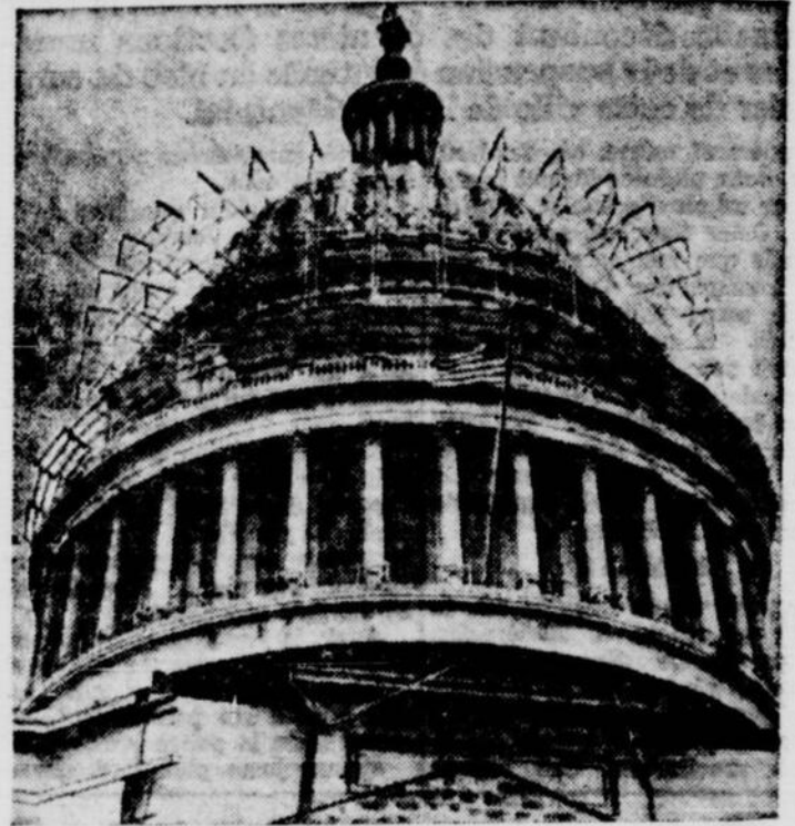
LE CAPITOLE HERISSE D'ECHAFAUDS — Un échafaudage à l'aspect revêche coiffe le dôme du Capitole, célèbre édifice de Washington, qui subit un examen d'importance de la part des spécialistes cherchant à savoir jusqu'à quel point le temps le marque de son usure. Dans le bas de la vignette, on aperçoit une section de la façade est, que l'on prolongera de 32 pieds.
