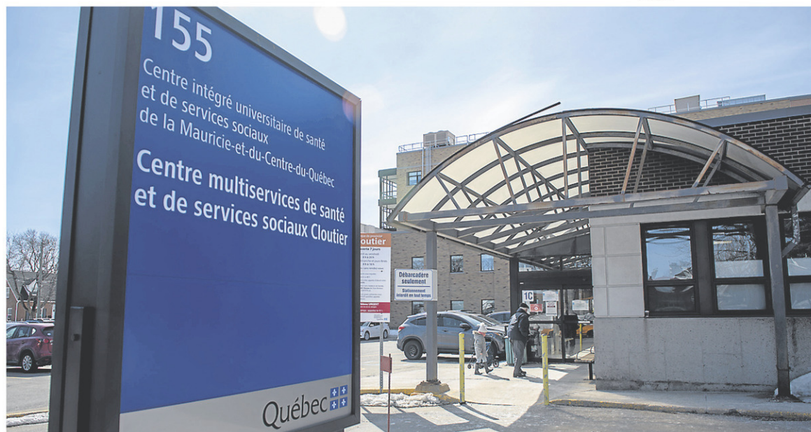
Le CHSLD Cloutier-du-Rivage a continué de voir son bilan s'alourdir de façon plus prononcée qu'ailleurs. On y a recensé quatre nouvelles infections parmi les résidents et deux autres parmi les membres du personnel, ce qui porte respectivement les totaux à 30 et 16 cas confirmés pour les deux groupes. — PHOTO: FRANÇOIS GERVAIS
