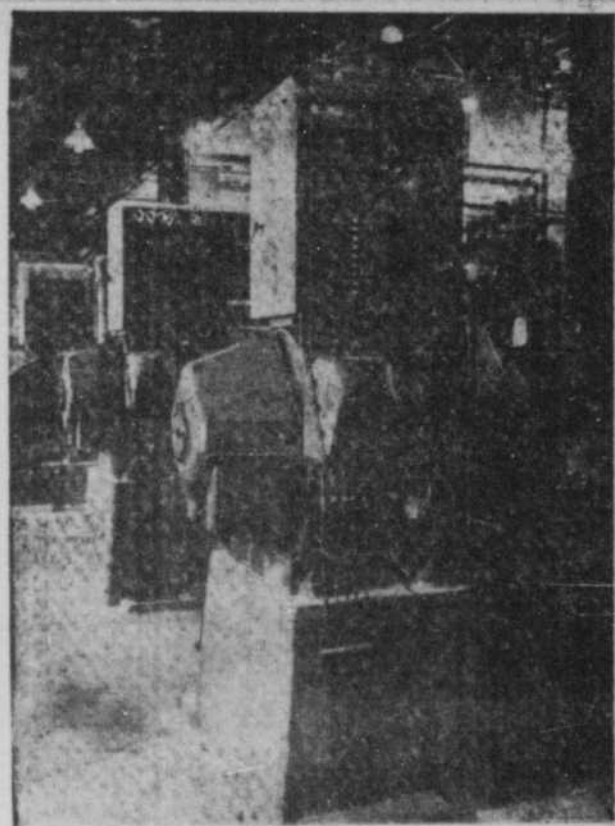
La photo ci-dessus nous fait voir les moteurs individuels de sections pour Machine à Papier No 2, utilisés à la Richmond Pulp and Paper Co.
