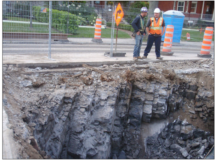
Photo 11 Grande Allée, sous-opération 1R, paroi sud, vue vers le sud (VDQ1406-NUM5-44)
