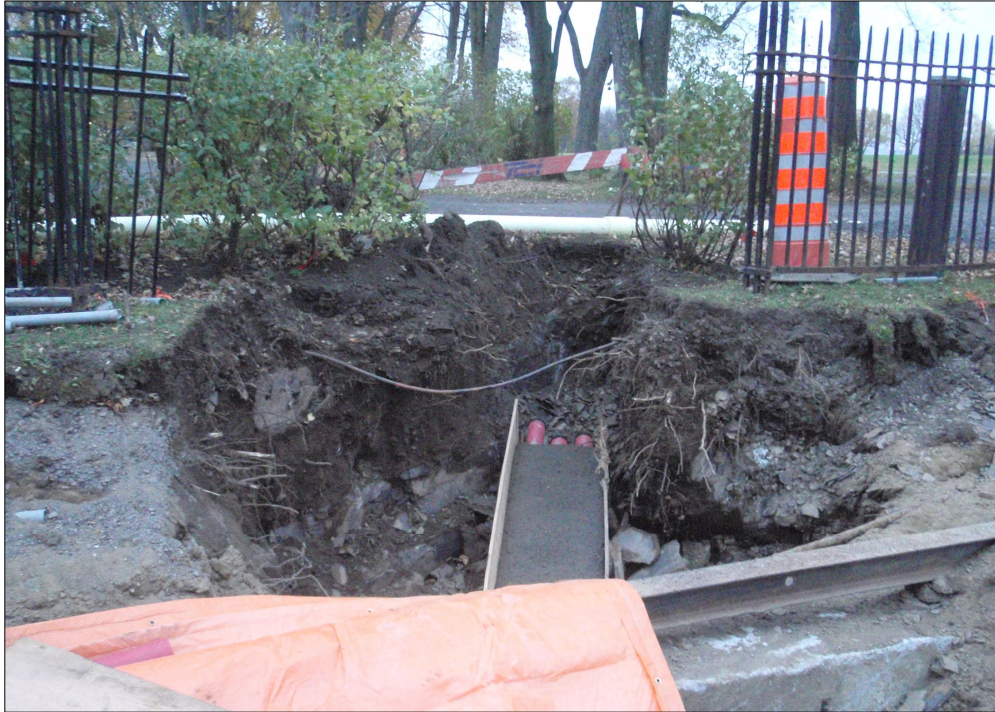
Photo 16 CeEt-911-7A, branchement de conduites de Bell, vue vers le sud (CeEt-911-14-NUM1-1)
