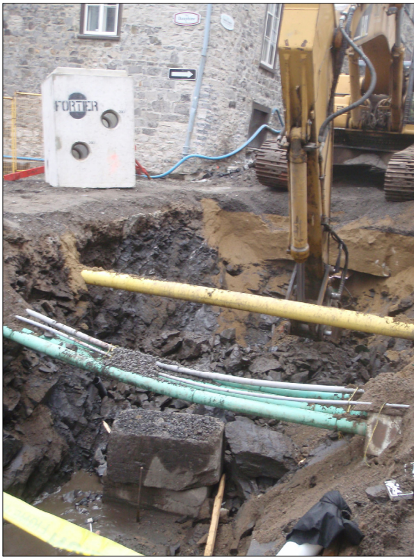
Photo 1 CeEt-923-4A, roc très haut sous le niveau d'asphalte, vue vers le sud-est (VDQ1406-14-NUM1-14)
