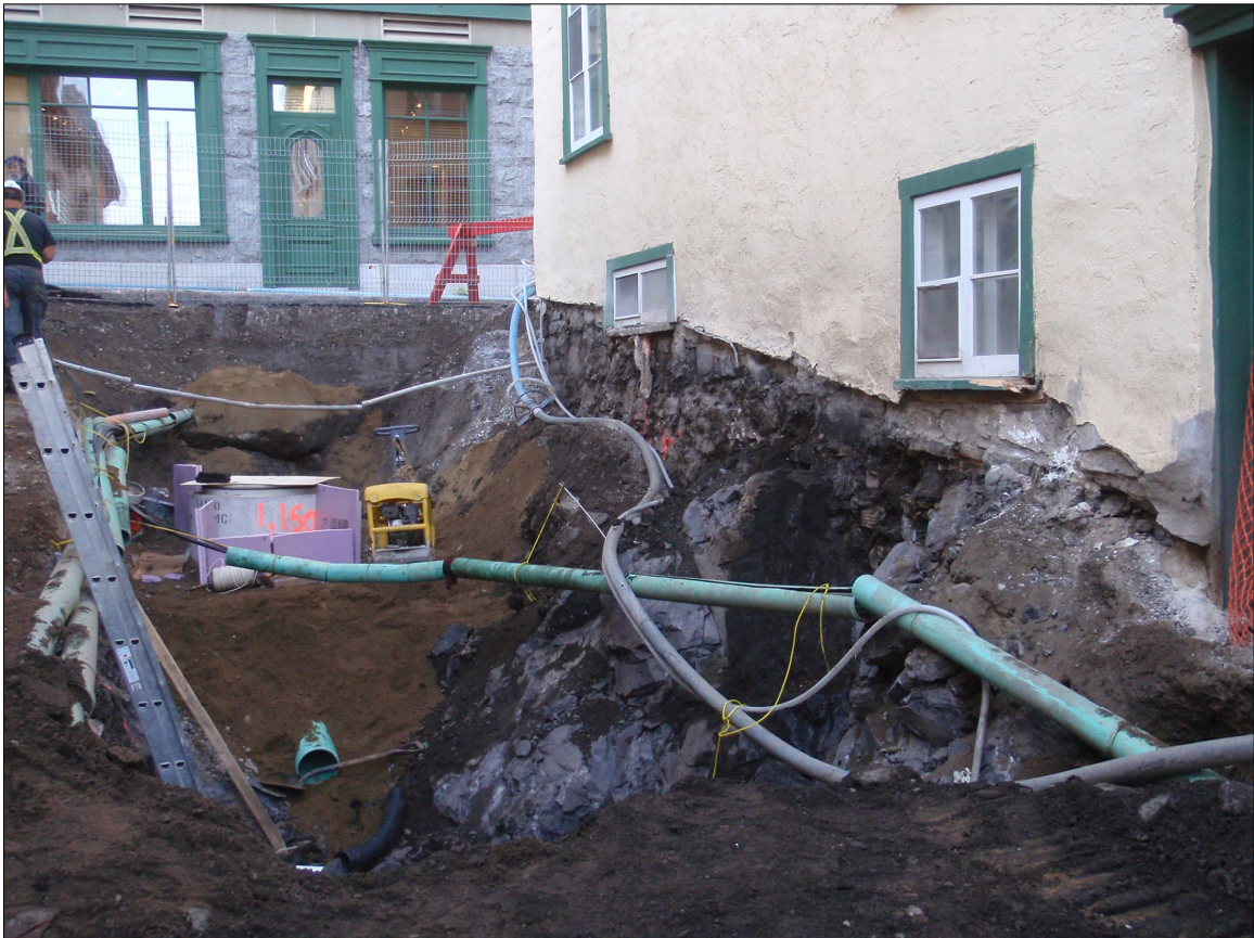
Photo 5 Rue Ferland sous-opération 1D, intersection avec la rue Garneau, roc et mur de fondation est du 12, rue Garneau, vue vers le sud-sud-ouest (VDQ1406-NUM2-22)
