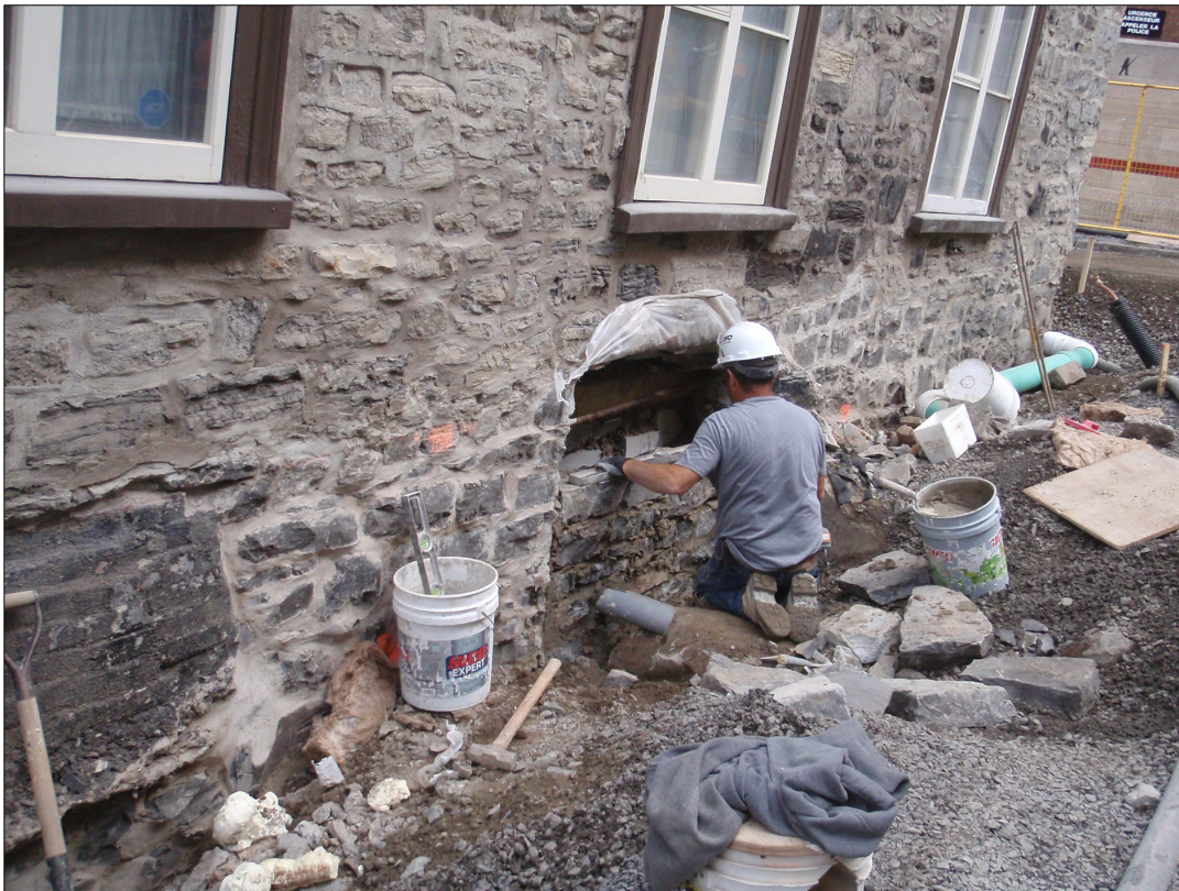
Photo 3 Rue Sainte-Angèle, sous-opération 1C, maçons travaillant à la réfection du mur ouest du bâtiment longeant le côté est de la rue, vue vers le sud-est (VDQ1406-14-NUM1-19)
