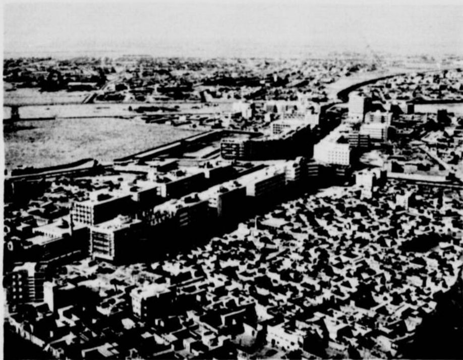
◁ Vue aérienne de la rue Cheik-Fahad, le centre des affaires de la ville, faisant ressortir le contraste entre l'ancienne et la nouvelle ville. Plus de dix îlots de l'artère sont bordés d'édifices de cinq étages, bureaux, hôtels et appartements. A l'avant-plan les maisons d'argile de l'ancien quartier.
