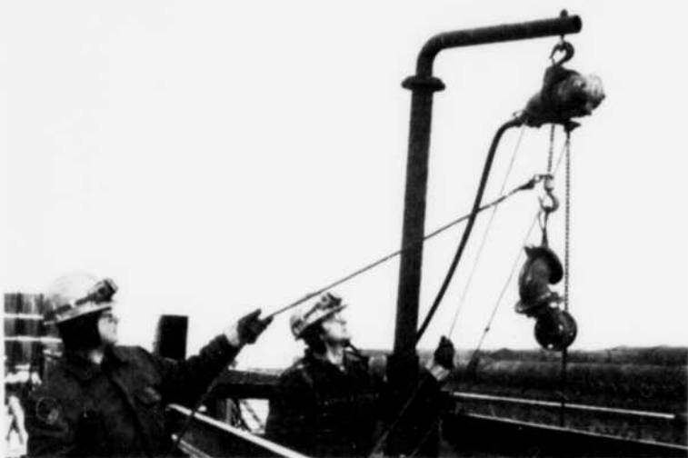
L'appareil est présentement installé sur le toit de la salle de cuves 53-N. Jacques Gauthier actionne le treuil pneumatique tandis que Rémi Bouchard guide la charge. (Photo Wilfrid Lafrance)
