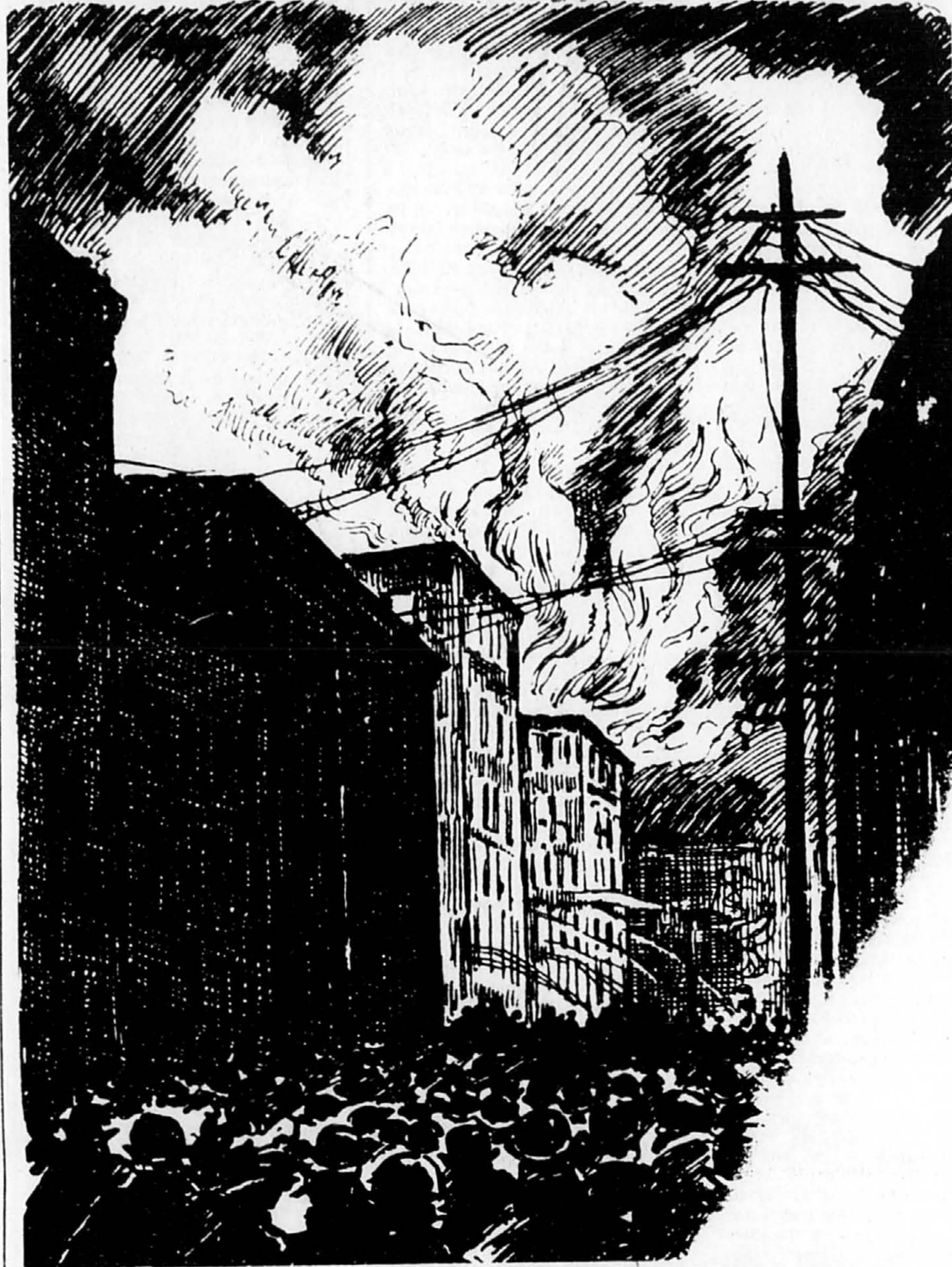
L'élément destructeur enveloppe complètement l'édifice du « Board of Trade ». Cette scène a été croquée par le dessinateur de LA PRESSE, installé un peu plus à l'est, rue Saint-Sacrement.
