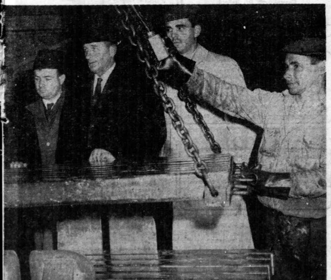
LES MOYENS modernes de manipulation du métal sont appréciés des visiteurs à l'usine de l'aluminium no 4. De g. à d. MM. Urie Pelletier de Chute-à-Caron, Frank Corbett de Shipshaw, René Gobeil des Forces motrices du Saguenay Limitée et Guy Lespérance de Chute-du-diable scrutent le travail de M. Urie Pelletier.
