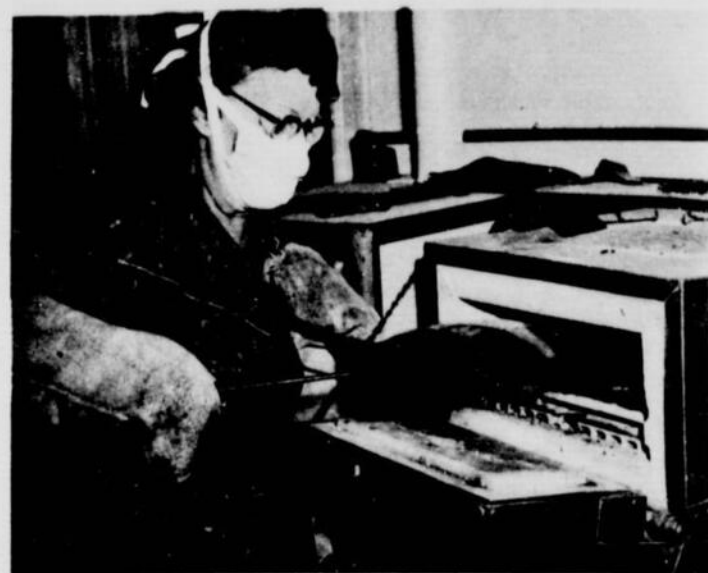
Pour sortir du four brûlant à 2,000 deg. F. les pièces cuites, il faut prendre des précautions: masque de chirurgien, lunettes tamisant la terrible lumière et, évidemment, surtout d'énormes gants d'amiante.
