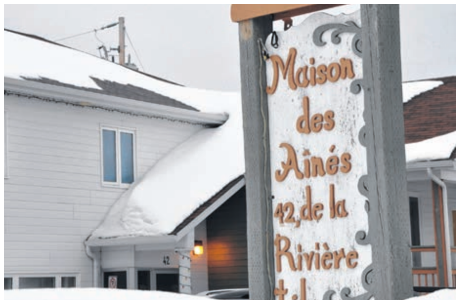
La Maison des Aînés pourra augmenter de 50 % sa capacité, de 20 à 30 unités de logement. (Photo Le Pharillon – Jean-Philippe Thibault)
