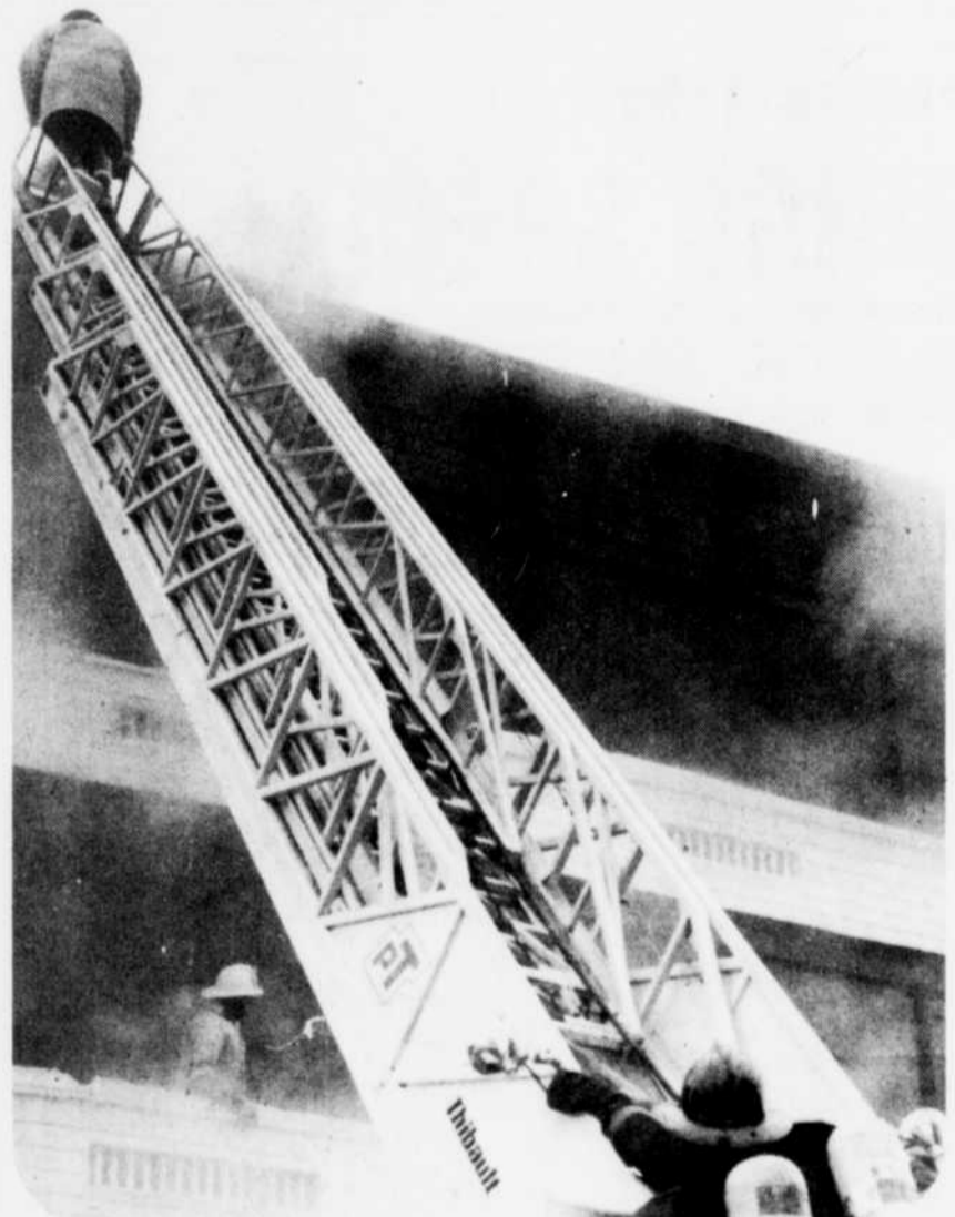
Un incendie ayant nécessité deux alarmes, dans un immeuble locatif de la rue Alexandre, et qui a causé pour au moins $40,000 de dégâts matériels, chez des gens qui n'étaient pas assurés pour la plupart, aurait pu se transformer en une véritable tragédie, aux dires des sapeurs, tellement les flammes se sont propagées vite. (voir nouvelle et autres photos en page 3)
