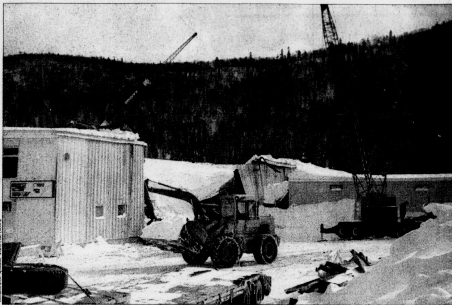
Depuis quelques jours, des grues mécaniques s'affairent à démolir l'une des trois sections du centre de distribution alimentaire Hudon et Daudehin ltée, à Rivière-au-Renard. Uniquement pour le bâtiment, la tempête hivernale du 5 février aura occasionné des dépenses de près de 2 millions $. L'entreprise J.-A. Brochet, propriétaire de l'entrepôt, se dit prête à reconstruire, mais elle attend pour le moment de connaître les intentions réelles de Hudon et Daudehin.
