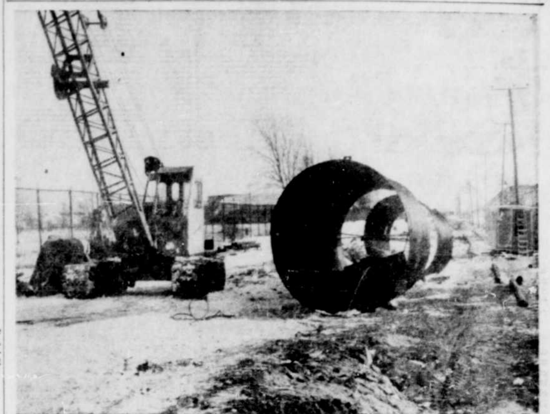
LA CONSTRUCTION de l'égout collecteur de la rue Père Daniel sera l'entreprise la plus considérable encore réalisée pour la municipalité dans ce domaine. La photographie ci-dessus nous donne une juste idée de l'ampleur que prendront les travaux. Il s'agit d'enfouir à quinze pieds sous terre des tuyaux d'acier de huit pieds de diamètre, comme ceux qui apparaissent ici. Avant de creuser la tranchée qui les recevra, il faudra égoûter le sol. C'est ce qui explique la présence du tuyau de diamètre sensiblement réduit sur les lieux. Les travaux s'amorcent au coin des rues Bellefeuille et Père Daniel.
