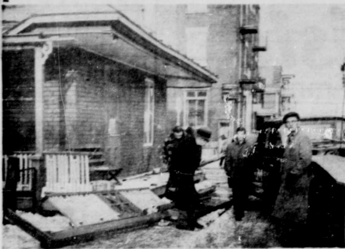
PRES DE LA GALERIE fauchée, on s'affaire au touage de la camionnette responsable de ce dégât. L'incident est la conséquence d'une collision entre ce véhicule et une auto.
