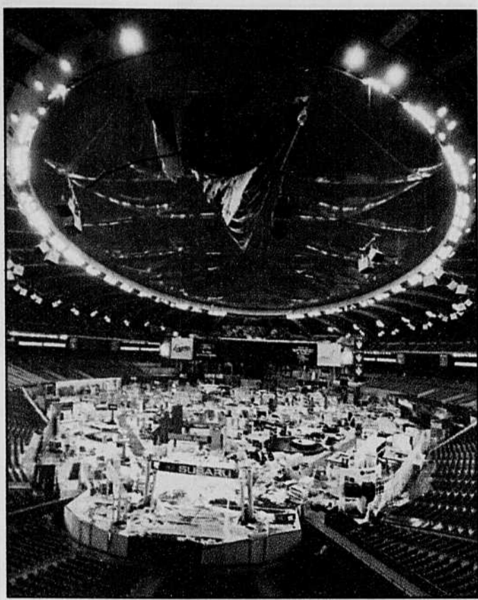
La toile du Stade olympique s'est déchirée, hier, pendant les préparatifs du Salon de l'auto. Photo PC
