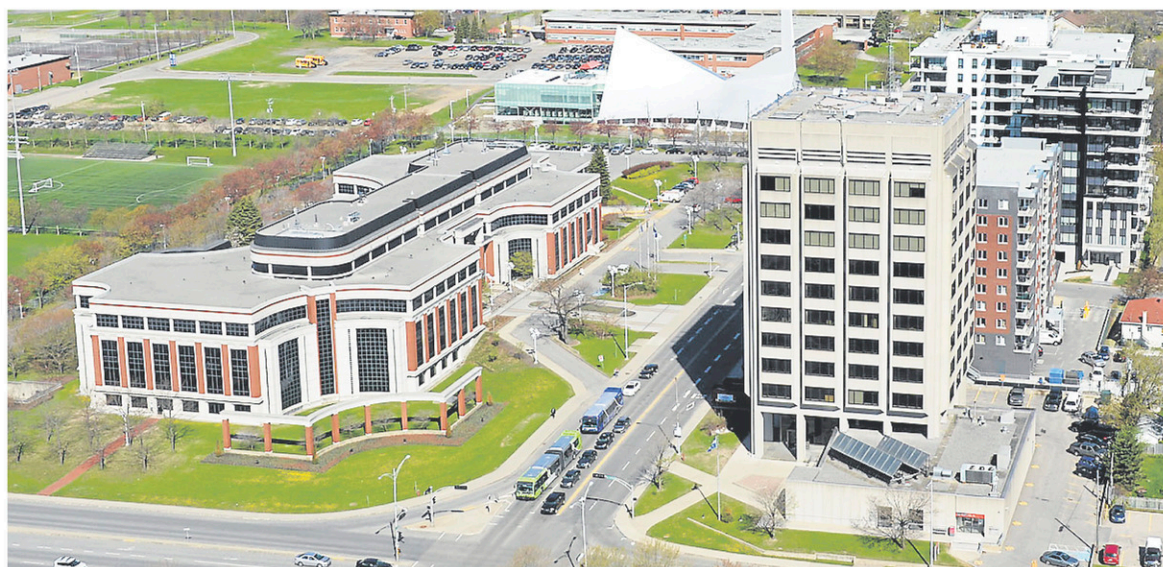
Parmi les projets inclus dans le programme triennal d'immobilisations, la réhabilitation et la réfection de chaussées et le réaménagement de la route de l'Église (photo) en rue conviviale nécessitent 83,2 millions $. — PHOTOTHÈQUE LE SOLEIL, PASCAL RATTHÉ
