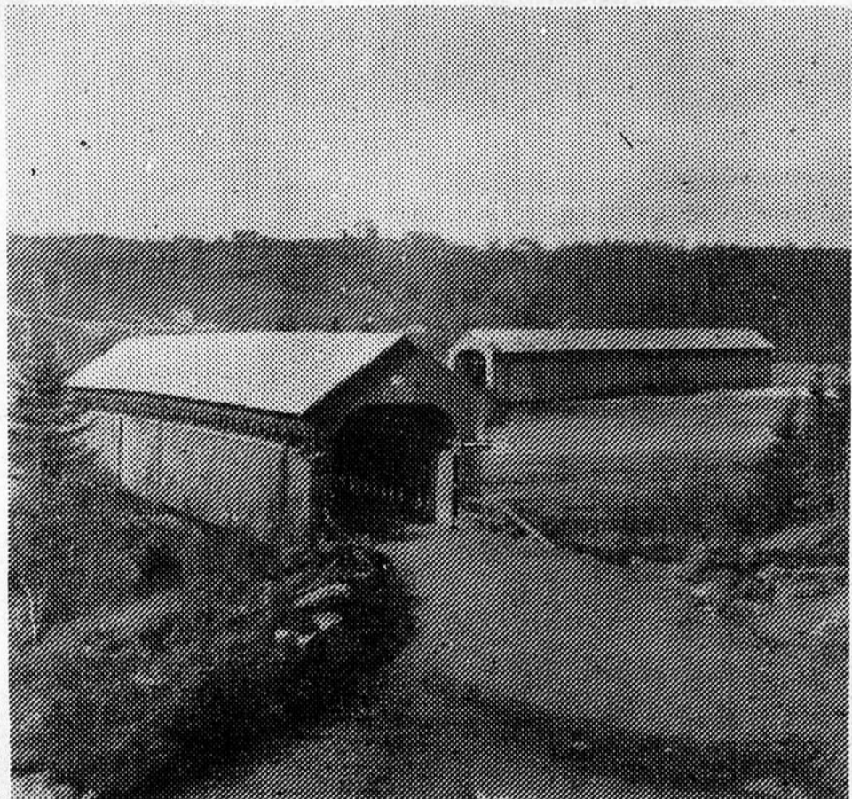
ALMA — Le pont Taché, d'une longueur de 500 pieds et qui reliait Saint-Joseph d'Alma à Saint-Coeur-de-Marie et que l'on considérait comme une véritable relique d'architecture, a été emporté par la crue des eaux, comme un grand nombre de ponts moins importants et de ponceaux. A Alma, la situation fut alarmante pendant plusieurs jours.
