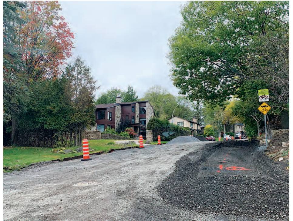
Les travaux permettront notamment l'ajout d'un trottoir sur la rue du Sommet-Trinité. (Photo : Gabriel Provost)
