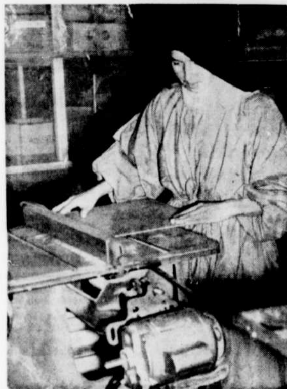
Les travaux de réparation nécessitent non seulement de l'outillage, mais aussi des mains expertes. La communauté possède les deux, à en juger par cette jeune religieuse qui travaille à la scie mécanique.
