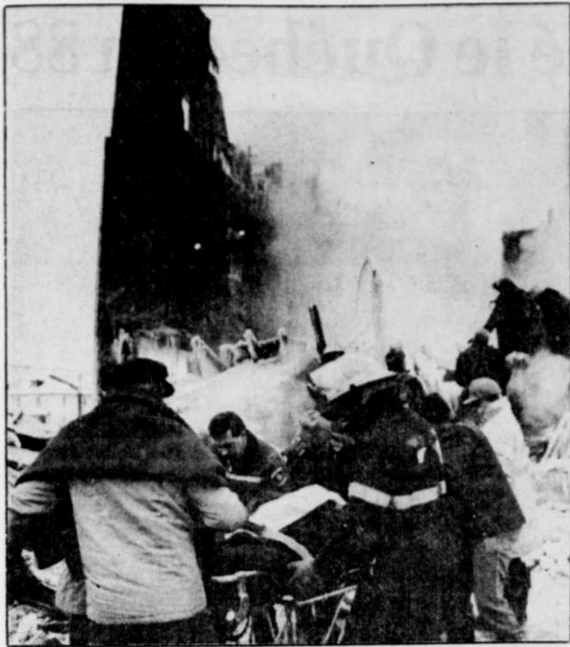
Le 9 décembre, un incendie d'origine criminelle éclatait à l'Hôtel du Boulevard, à Saint-Georges-Ouest, causant la mort de deux personnes.
