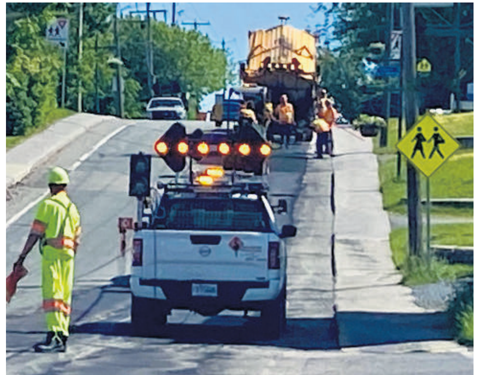
D'ici la réalisation des travaux d'asphaltage, des opérations de rapiéçage mécanisé sont programmées cet été sur la route 249, à Windsor.
