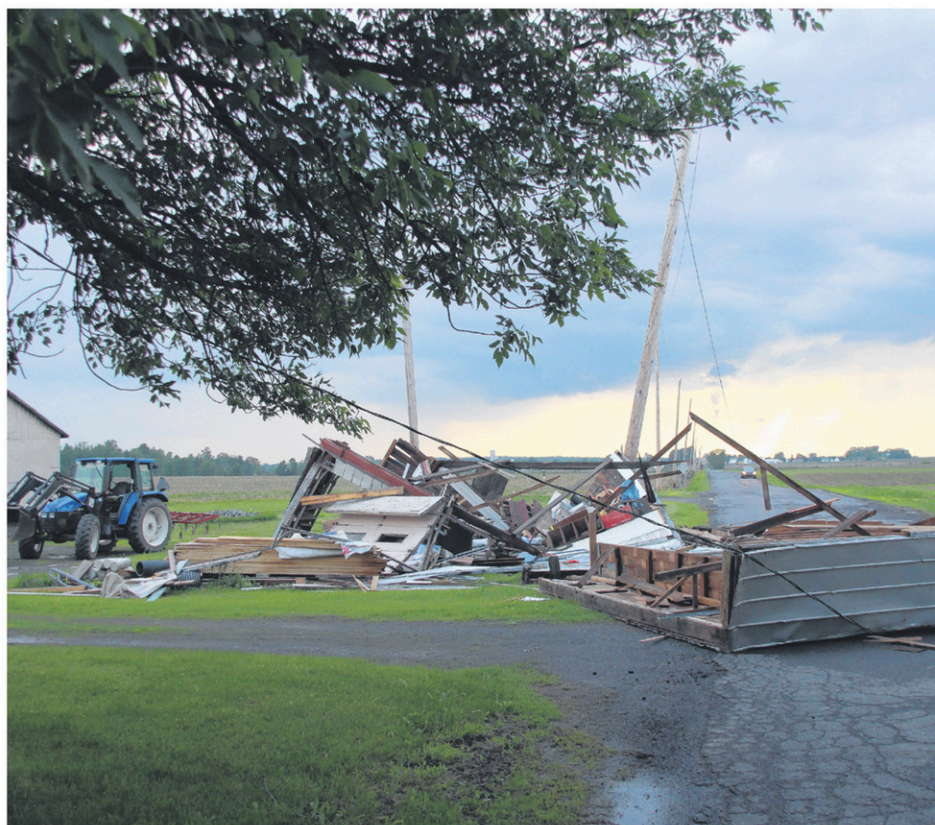
Un garage a été soulevé par le vent sur la montée Odelltown, à Lacolle. (Photo Patrick Taillon)
