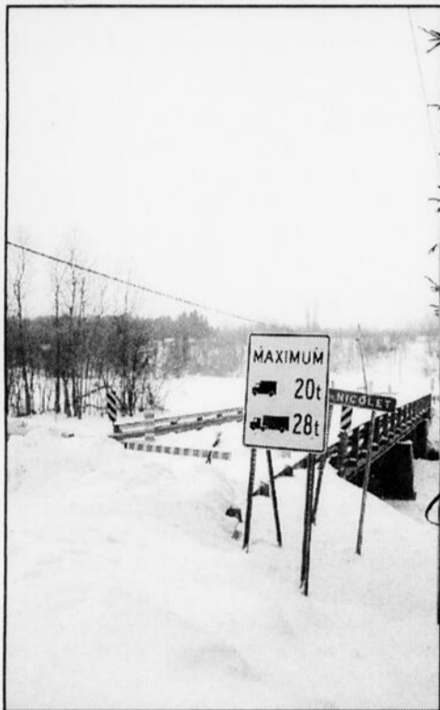
LE PONT DE LA RUE DU MUGUET à Saint-Christophe sera démolé au cours des prochains jours.
