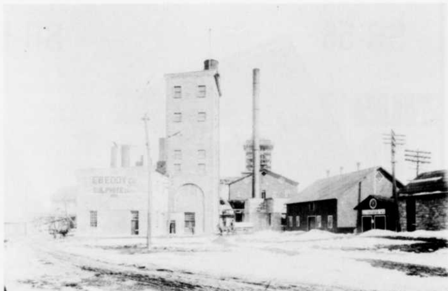
TOUR DU LESSIVEUR DE LA COMPAGNIE E.B. EDDY — 1901. E.B. Eddy fut la première compagnie au Canada à se servir d'un lessiveur vertical pour le traitement au sulfite de la pulpe à papier. Cette technique permit la fabrication plus économique d'un papier de meilleure qualité.
