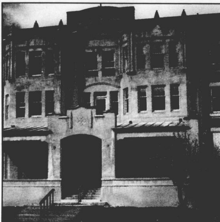
C'est une entreprise de Saint-Léonard qui a obtenu le mandat d'effectuer les travaux de rénovation du Château de Huntingdon. Ceux-ci doivent commencer au cours de la semaine prochaine. (photo d'archives)
