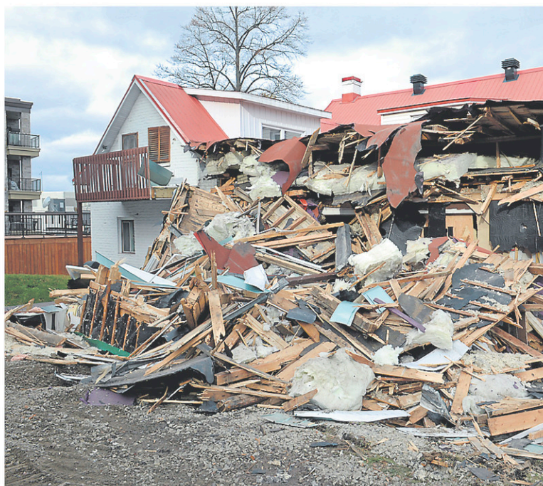
Les travaux de démolition de la Maison Bossé ont débuté mercredi et devraient se poursuivre pendant trois jours. — PHOTO LE QUOTIDIEN, MARIANE L. ST-GELAIS
