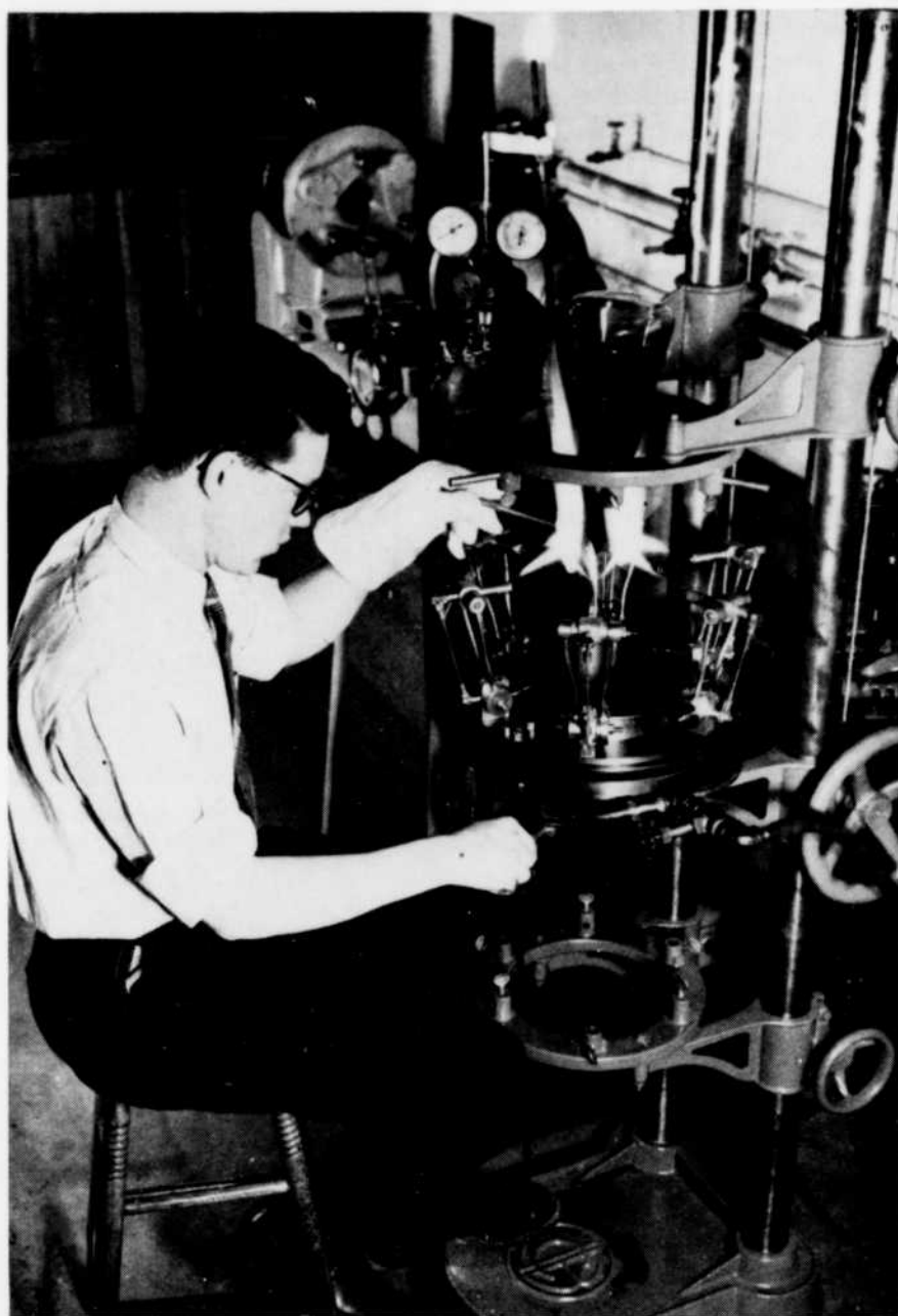
Scellement au tour à verre vertical d'un tube électronique spécial.
