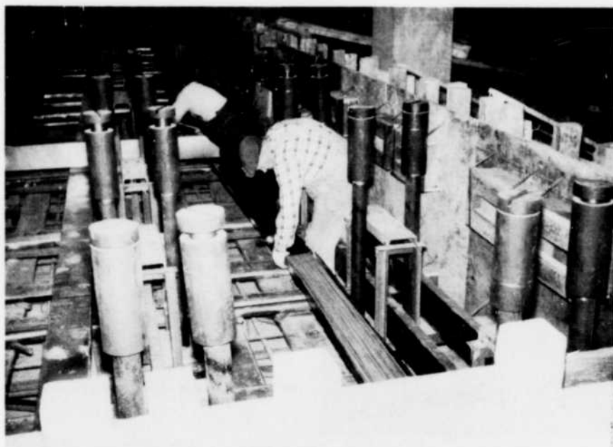
Dalle d'essai du laboratoire des travaux publics. Mise en place des fils de précontraint.
