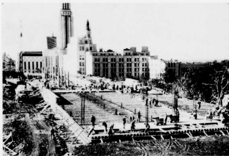
Première coulée importante, la dalle du plancher 510, section "A". 424 verges sont placées en 6 heures. (21 septembre 1955).
