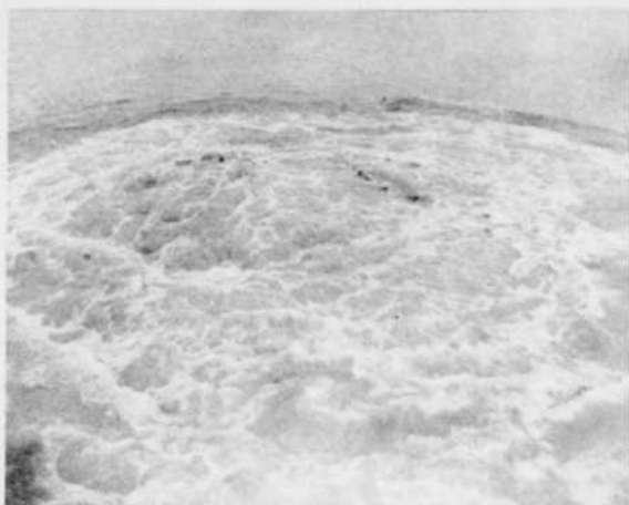
Les bulles de gaz qui crèvent à la surface sont le seul indice de cette opération de sautage sous l'eau pour laquelle on a fait usage de la technique à retard fractionné.
