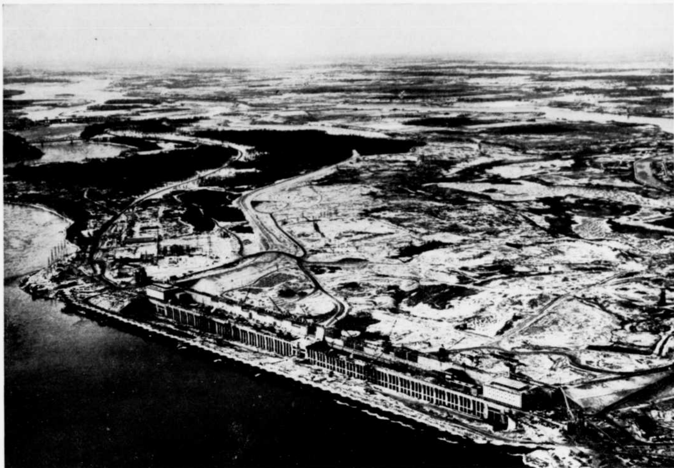
La centrale électrique de Cornwall en voie de construction. La région d'arrière-plan a été inondée. (Gracieuseté de l'Hydro-Ontario)
