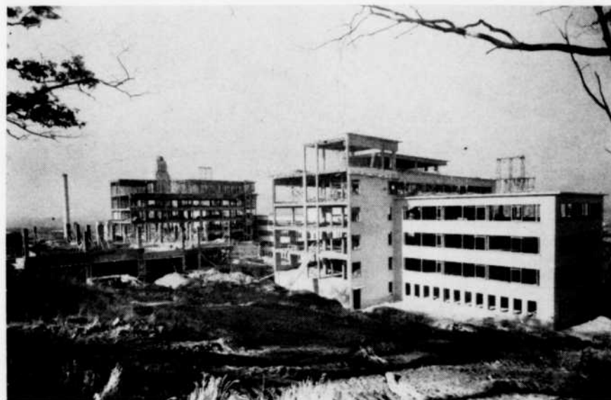
Vue générale de l'arrière vers l'ouest. (septembre 1956).
