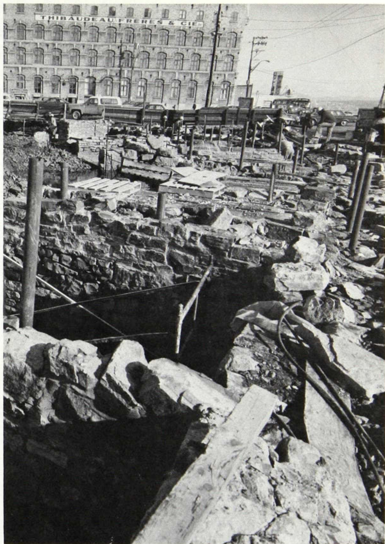
Figure 31 — Des injections verticales de ciment dans les murs ont été nécessaires pour assurer la solidité de la base des murs restaurés (photo Roger Picard)
