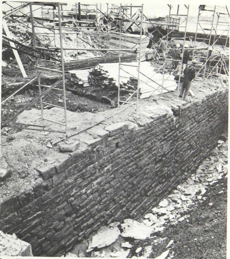
Figure 22 — Les archéologues font construire un abri sur la moitié sud de la batterie pour y poursuivre les fouilles au cours de l'hiver 1974-75 (photo Alfred Piché)
