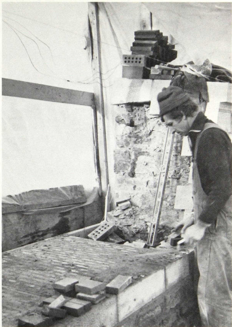
Figure 33 — Comme un de ses ancêtres, 250 ans plus tôt, le maçon met toute son application dans la construction du glacis en brique d'une embrasure (photo Roger Picard)
