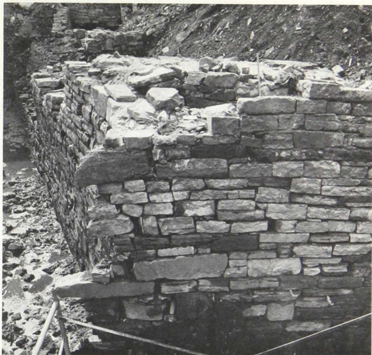
Figure 23 — L'angle formé par la face et le flanc nord avait été retouché quand le flanc nord a été prolongé pour servir de quai vers 1785 (photo Alfred Piché)
