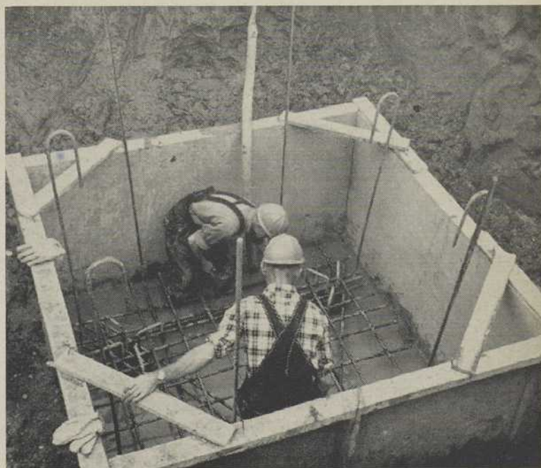
MISE EN PLACE DE L'ACIER D'ARMATURE D'UNE FONDATION DE BETON.
