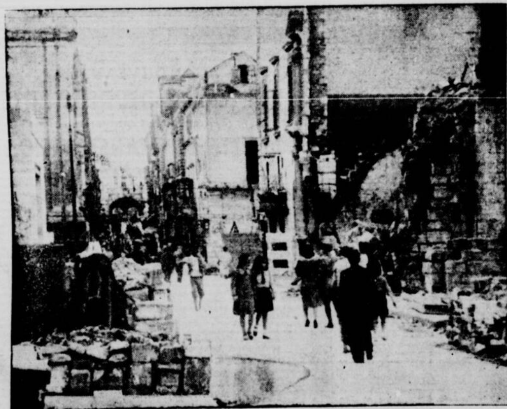
La rue principale de Malte possédait un nom italien. Lorsque l'Italie se rangea aux côtés d'Hitler, on suggéra de changer ce nom en un nom anglais. Les magasins, les églises et de nombreux autres édifices ont été détruits au cours des bombardements que les alliés ont fait subir à la ville.
