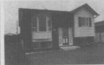
7 — LONGUEUIL: Bung. 83 avec terrassement asphalté terminé, construction supérieure. Contactez Pierrette M. Moreau 651-1000.
