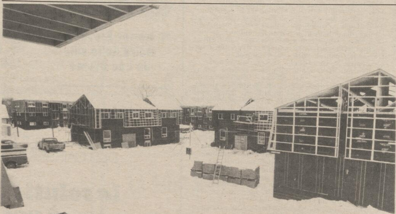
La construction va bon train et le "Carré Joyeux", site 3 des HLM prend de plus en plus forme. Il s'agit de six bâtiments, dont 2 blocs de 27 logements chacun. Ce complexe est situé entre les rues St-Joseph, Cowie et St-Antoine.
