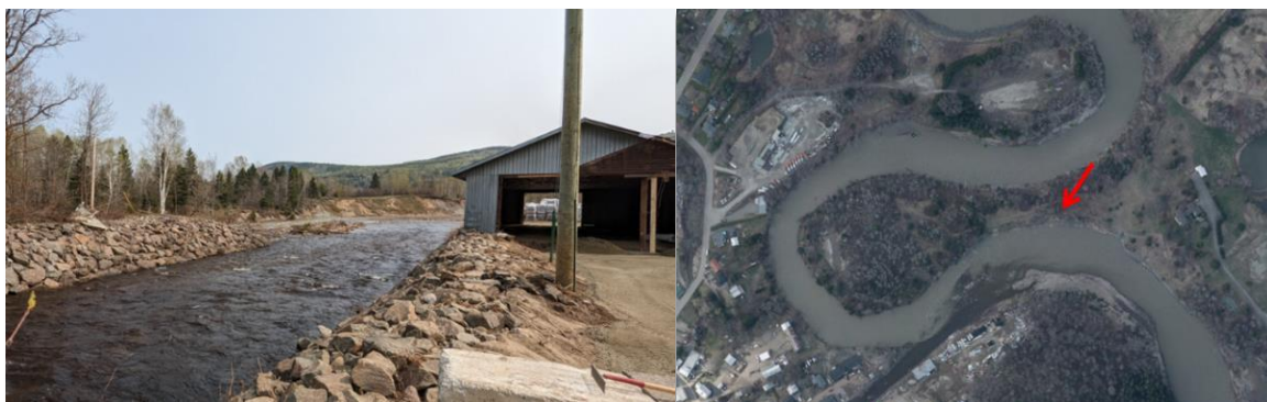
Figure 45. Secteur de la confluence des rivières du Gouffre et du Bras du Nord-Ouest. Ouvrage de la rue Saint-Pierre. Vue sur le pincement du méandre. Le talus est d'environ 10 mètres de hauteur (flèche rouge). Secteur inondé lors de l'événement
